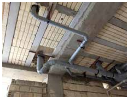
شکل ۲- نصب لوله‌های افقی به صورت زیر سقفی
