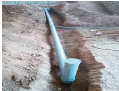
شکل ۱- نصب لوله‌های افقی به صورت کف خواب
